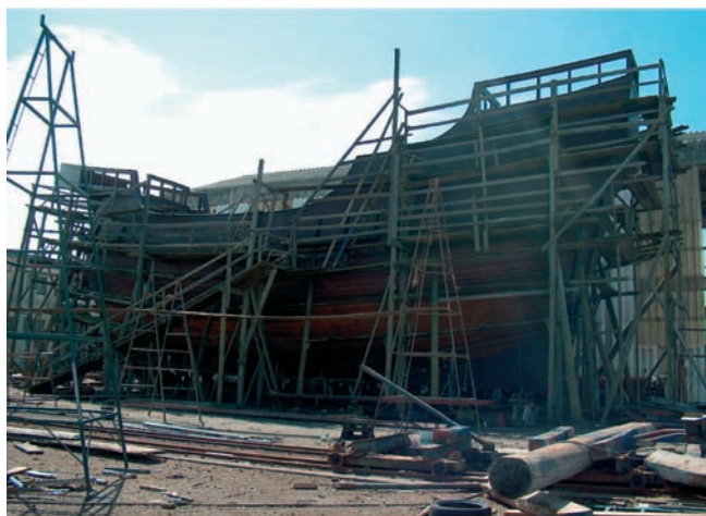
Construção da Nau de 18 Rumos para Museu Flutuante da Câmara Municipal de Vila do Conde Abril de 2004
