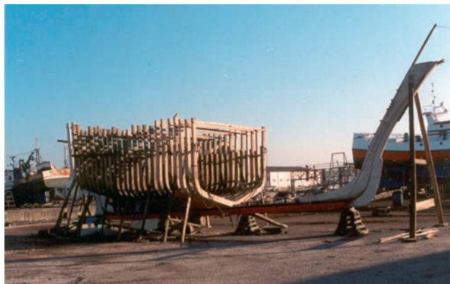
Estaleiro Sicnave Lda. Construção de uma nova embarcação para a pesca costeira. 2001
