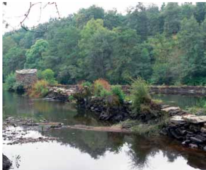
Imaxe dun caneiro situado no cauce do río Ladra
