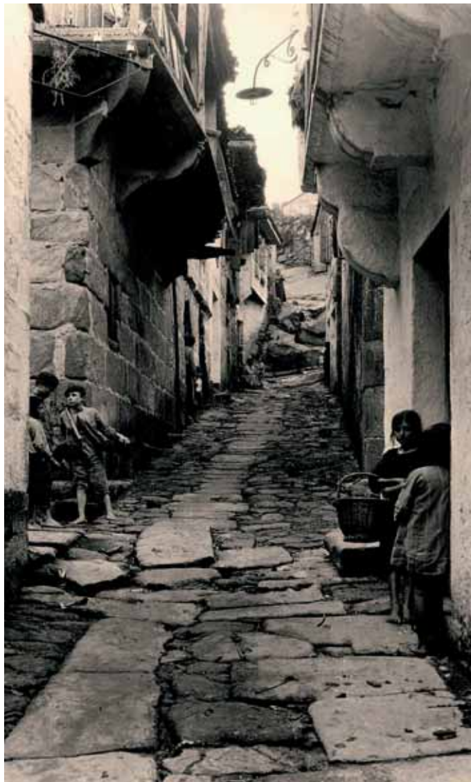
Muros segue a conservar as súas estreitas e empedradas congostras
